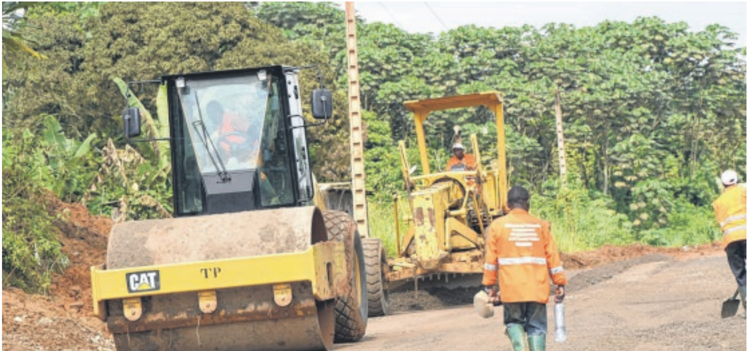
Une vue des engins des Travaux publics (TP).
